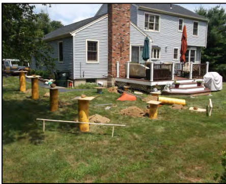
Excavate & pour footings
